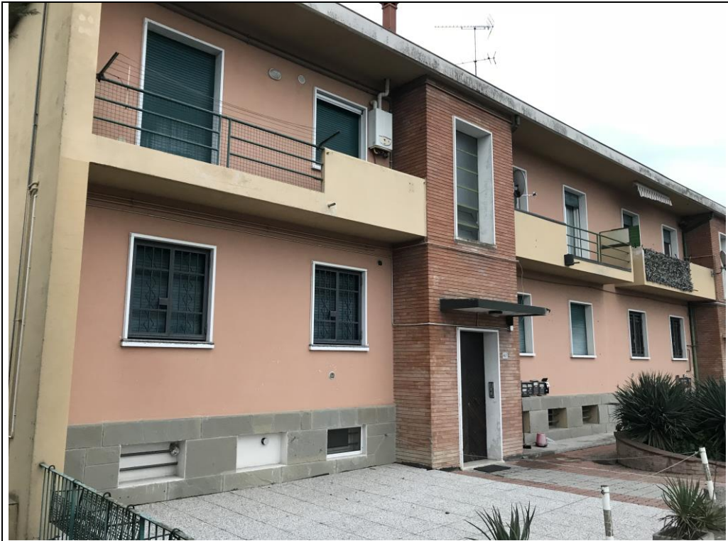
Fabbricato Via Altedo 4627 San Pietro in Casale BO
