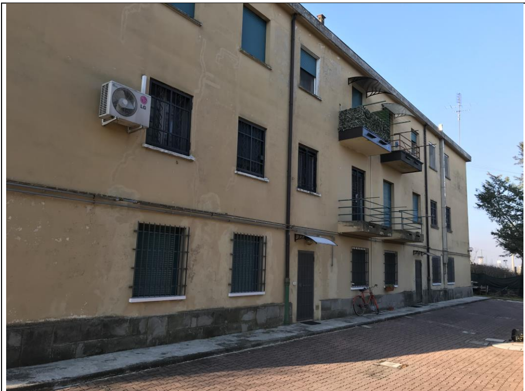
Fabbricato Via Altedo 4645-4627 San Pietro in Casale BO
