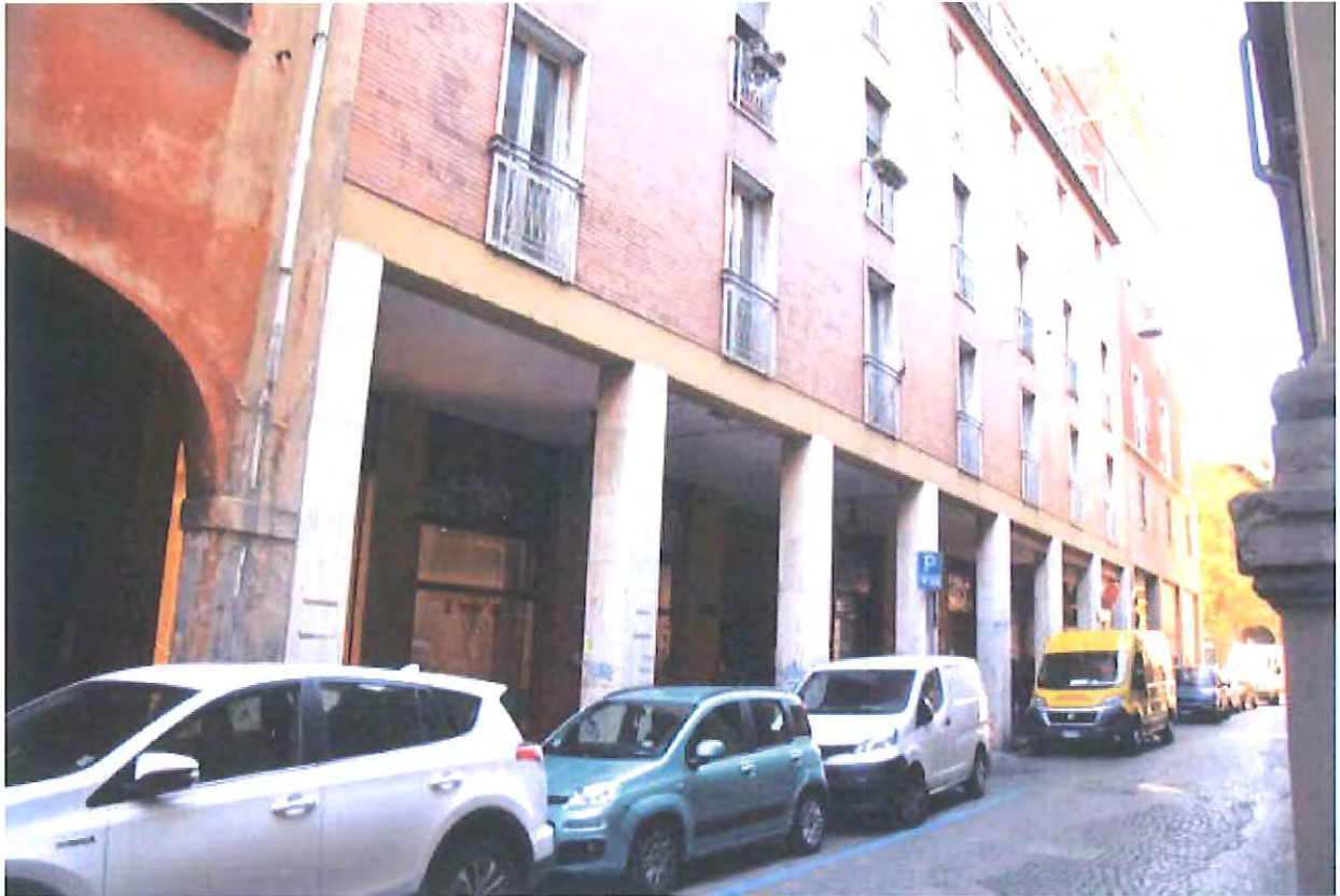
Prospetto su via Galliera
