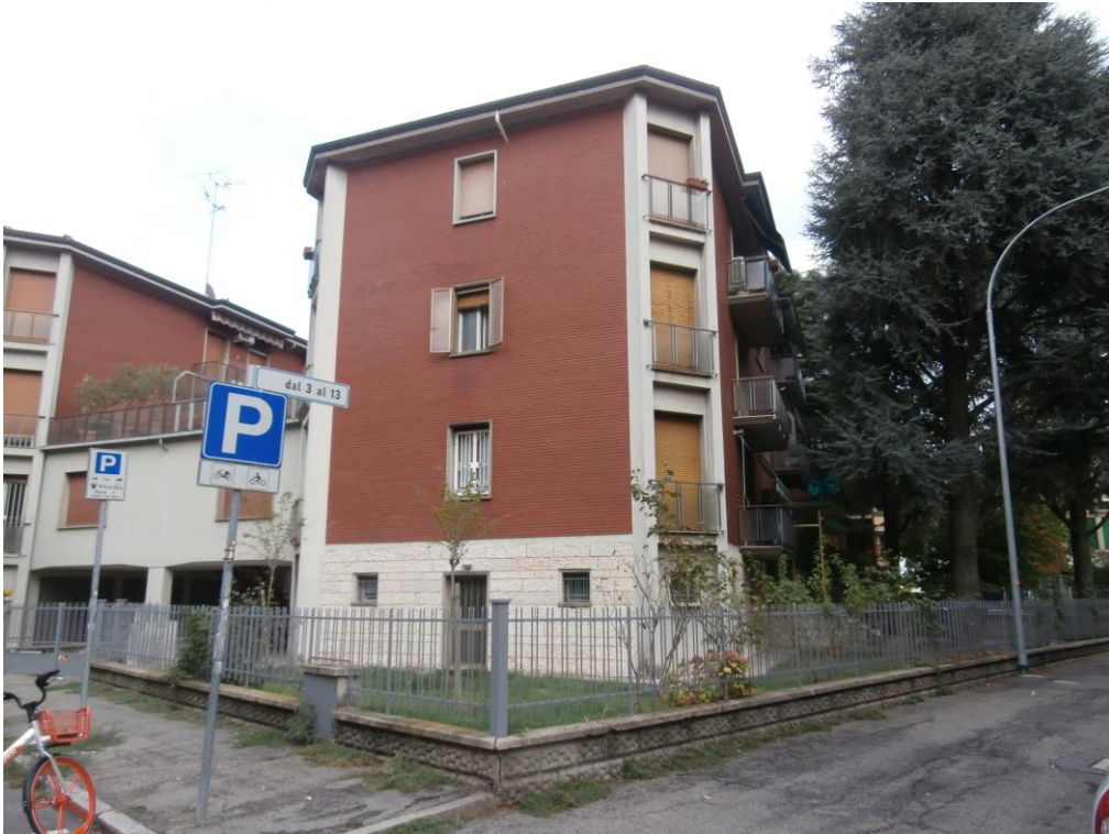
Esterno su via Solari
