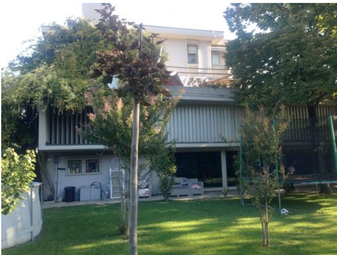
Vista dalla corte dell'edificio.
