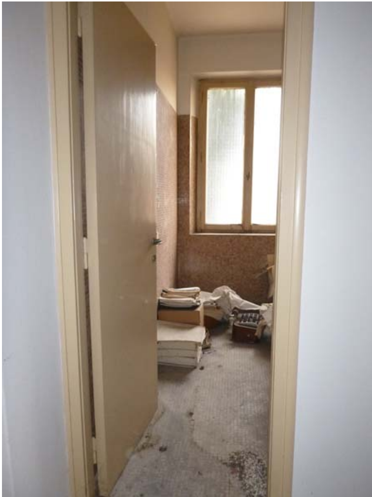
5. Un bagno al piano primo
