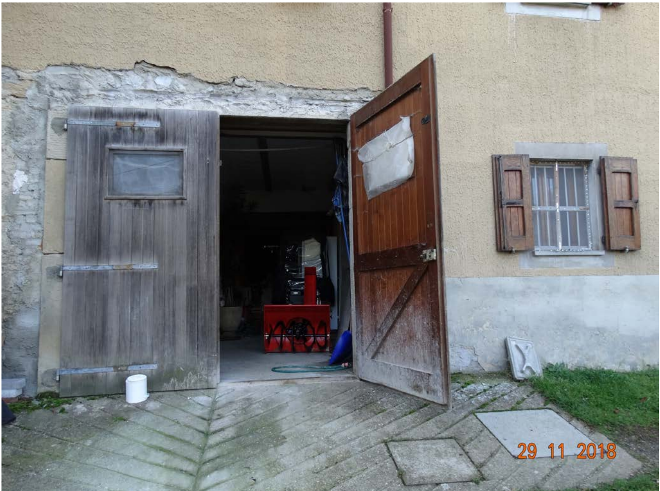
Foto n. 8 – Piano interrato. Ingresso all'autorimessa e cantine su terreno di altra proprietà.
