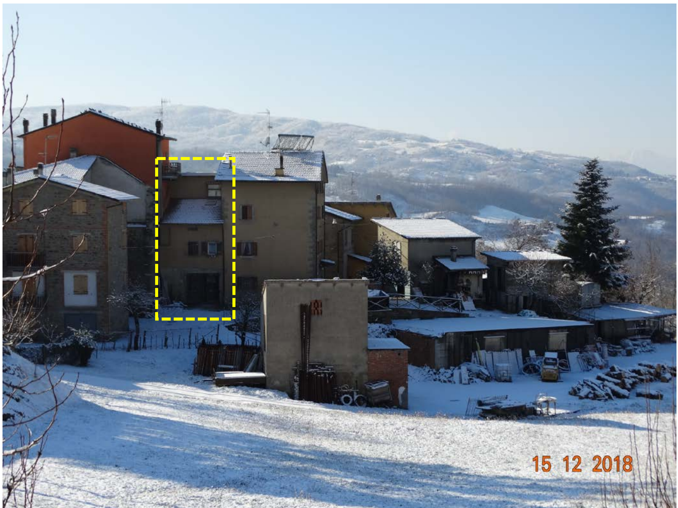
Foto n. 1 – Il piccolo borgo in via Pian dei Grilli e il fabbricato in esame
