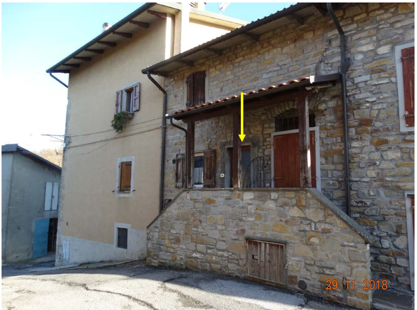
Foto n. 2 – Ingresso al fabbricato in esame. Ingresso scala non legittimo.
