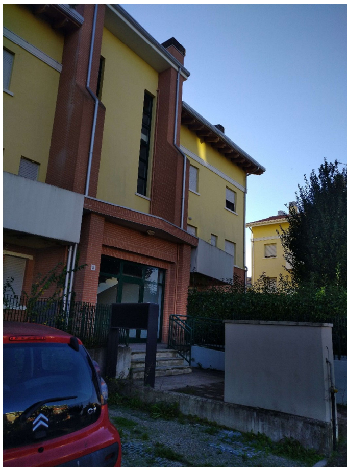
Vista esterna della palazzina
