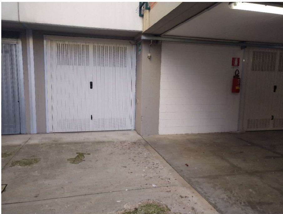
Vista dei garage nell'interrato
