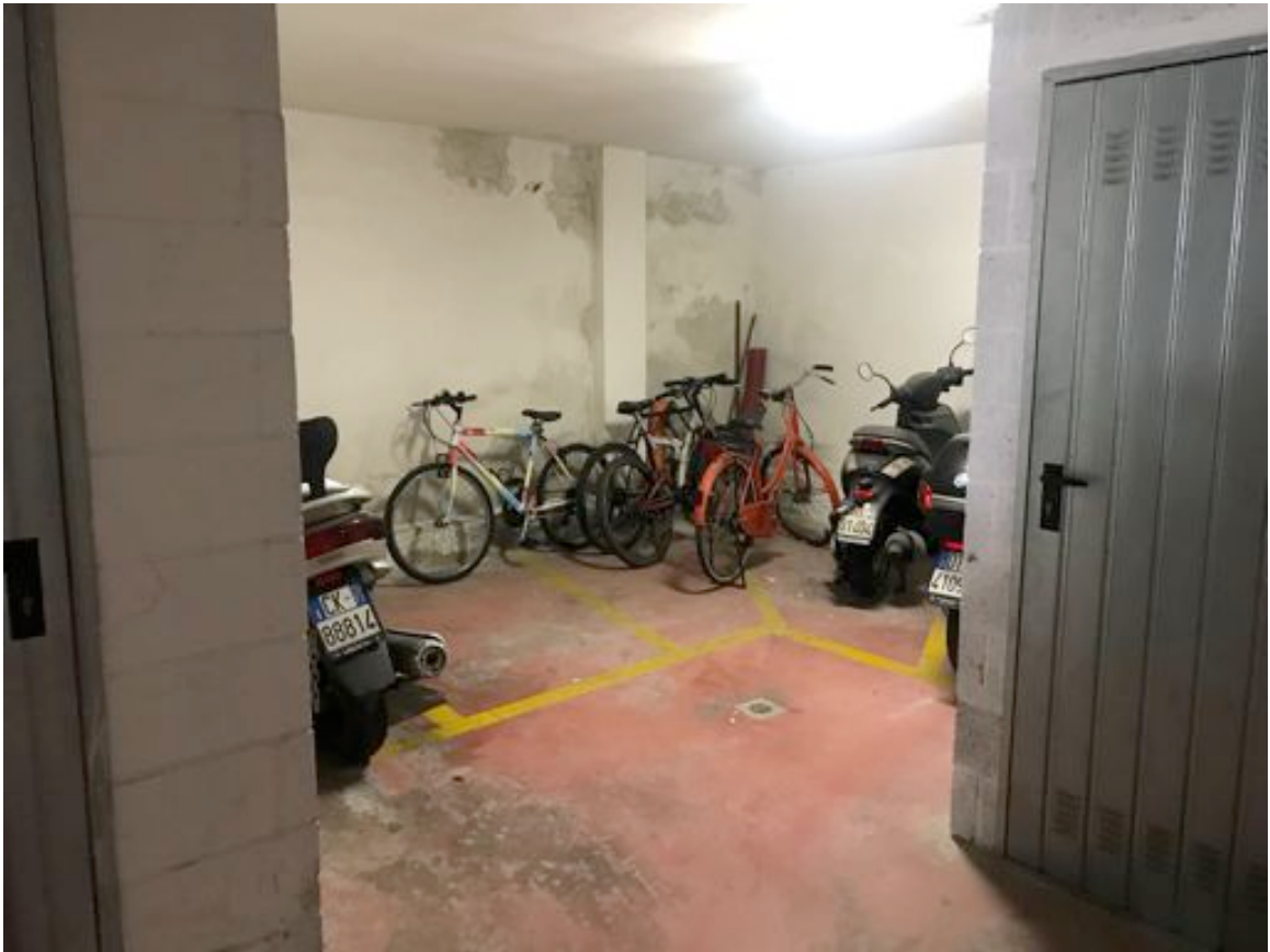
Vista del corsello al p. interrato verso i Sub 113 – 114 – 115 – 116 a posti moto.
