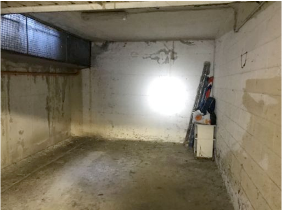
Vista dell' autorimessa Sub 69.
