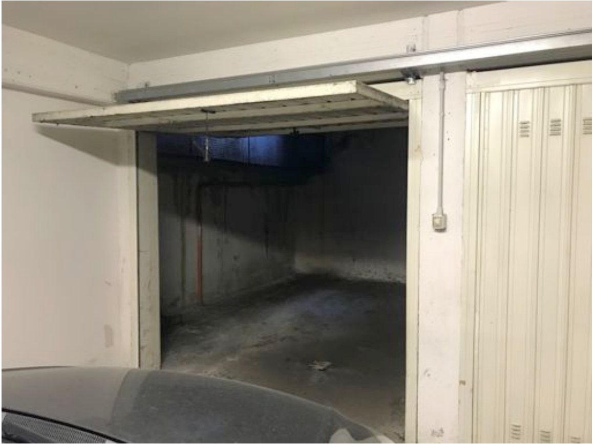
Vista del corsello al p. interrato verso il Sub 69.
