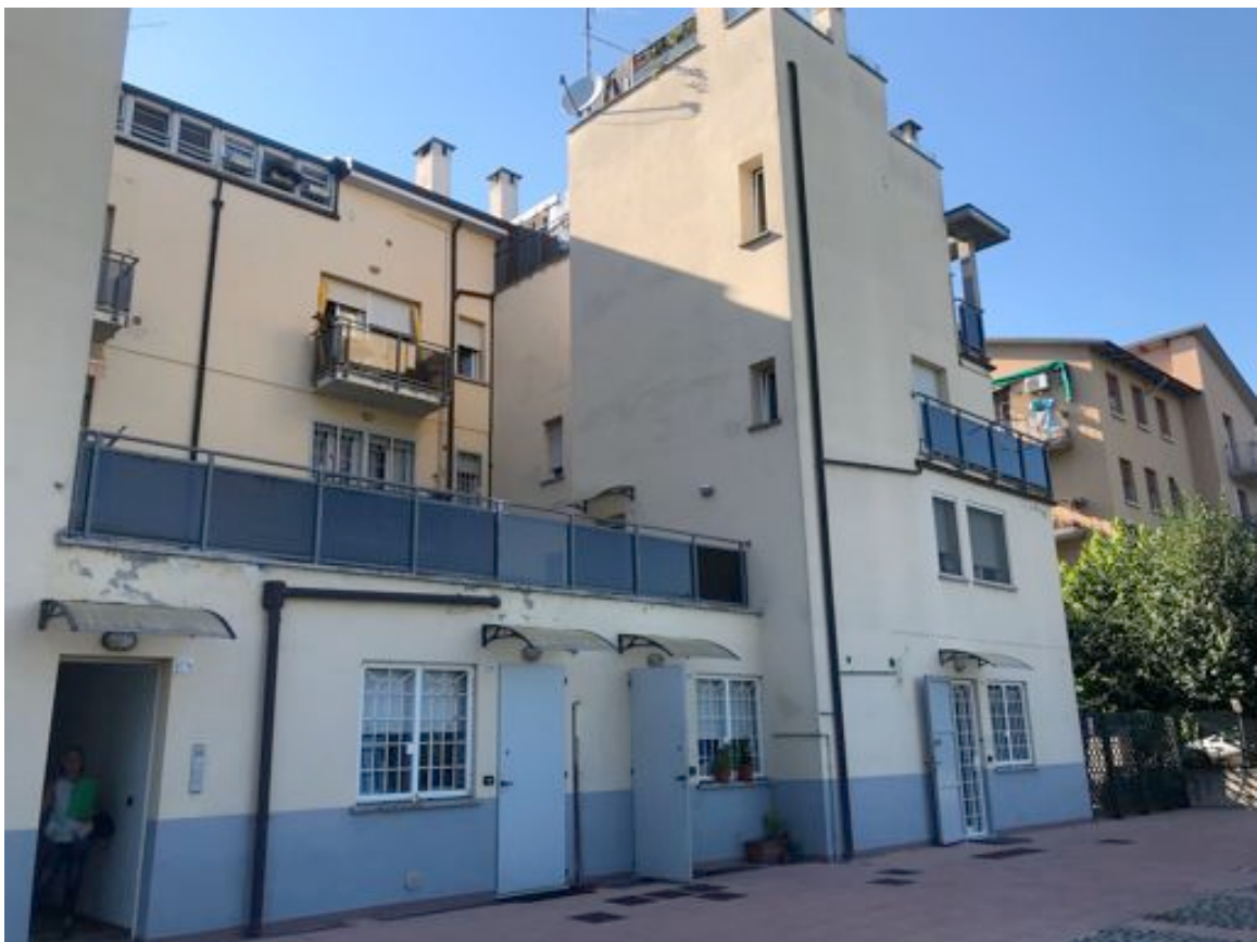
Vista dalla corte comune del fronte retrostante.
