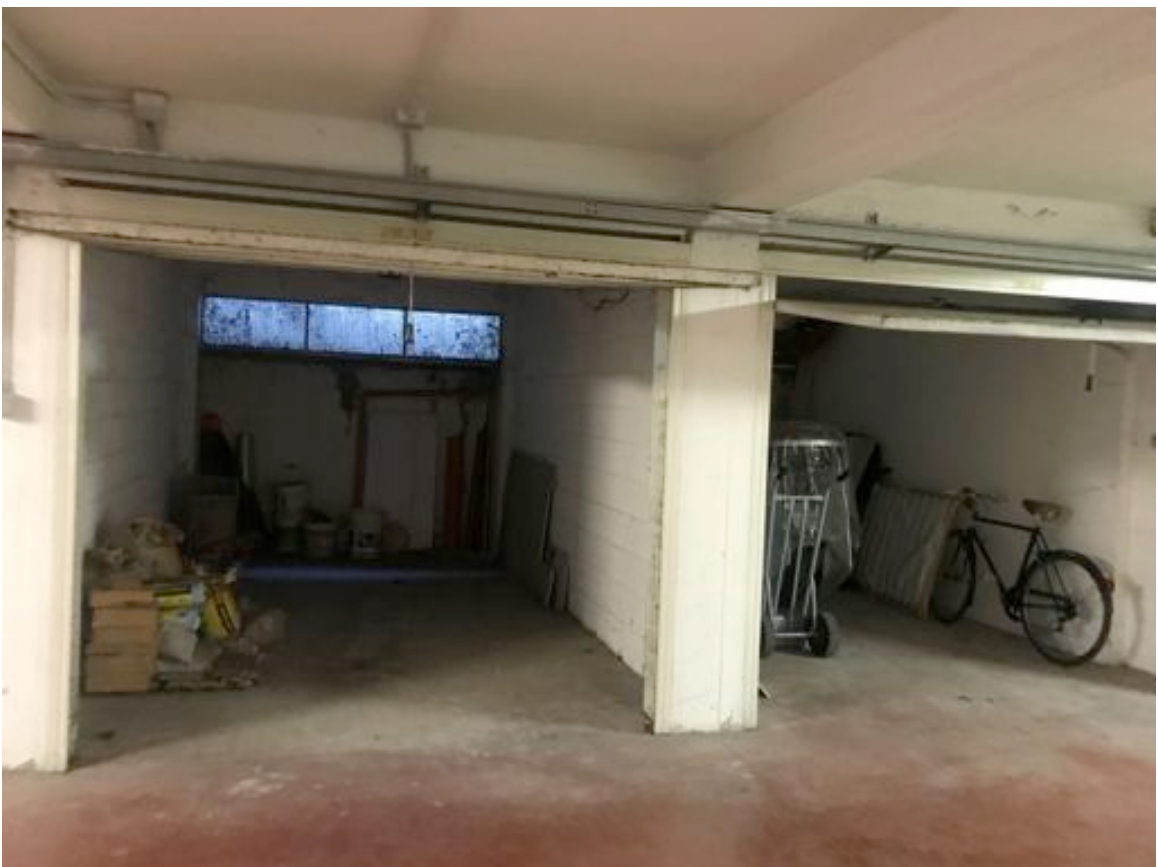
Vista dell'autorimessa Sub 63 sulla sinistra .
