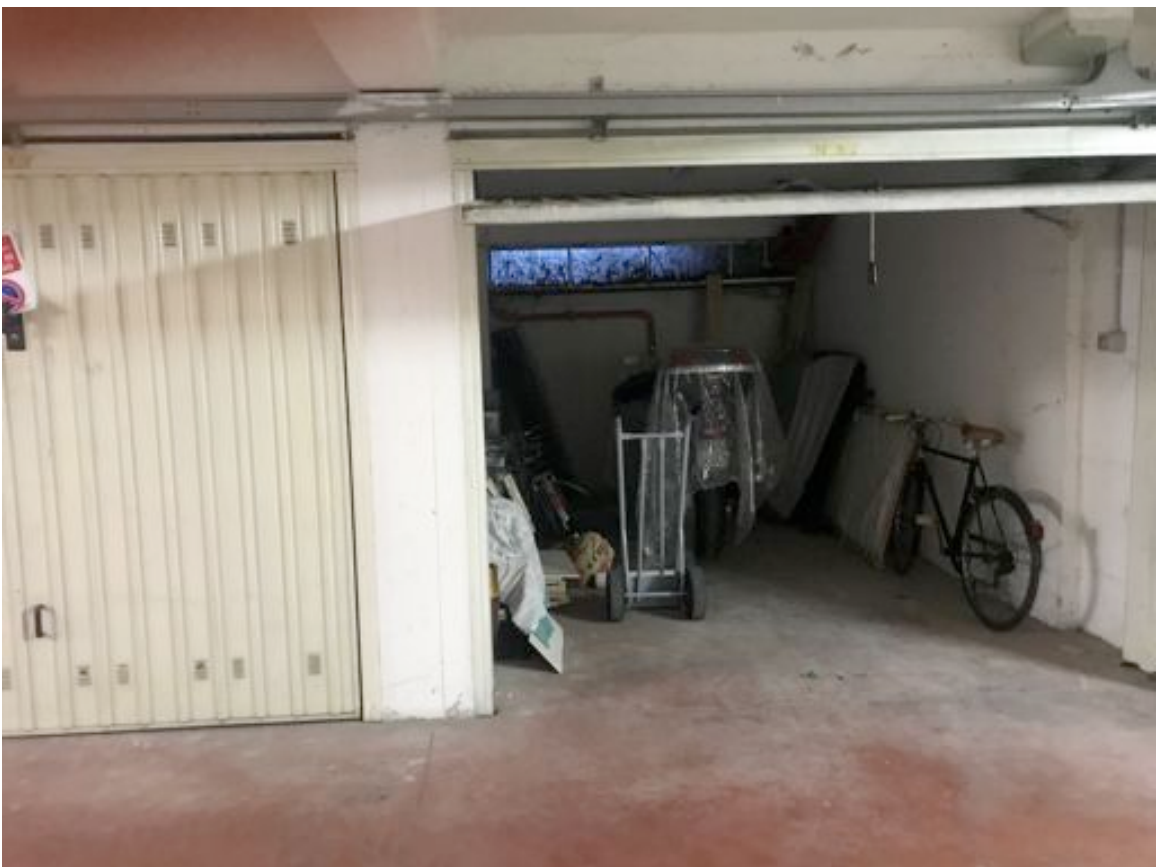
Vista dell'autorimessa Sub 62.
