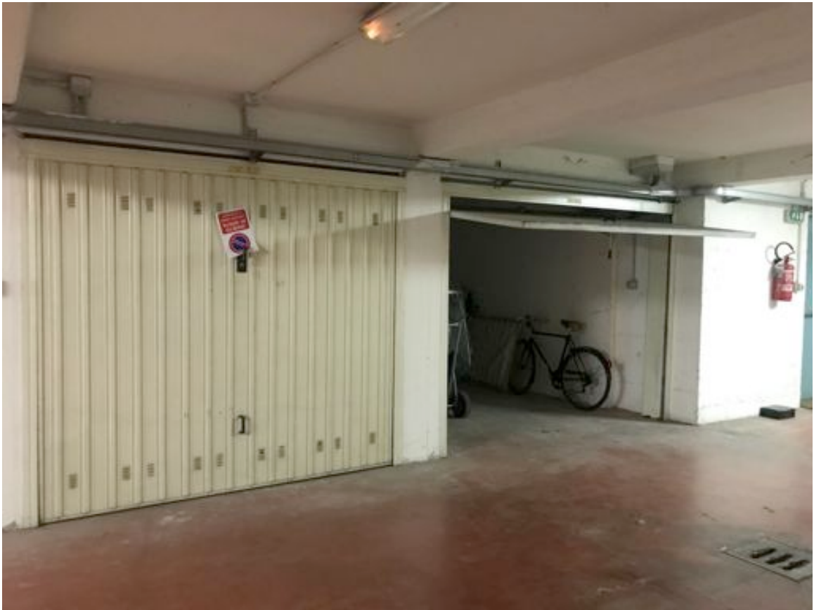
Vista del corsello al p. interrato verso il Sub 62.
