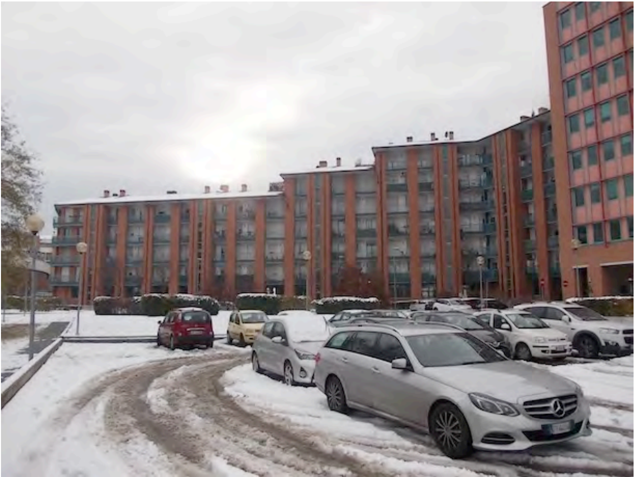
Lo stabile di cui l'immobile è parte
