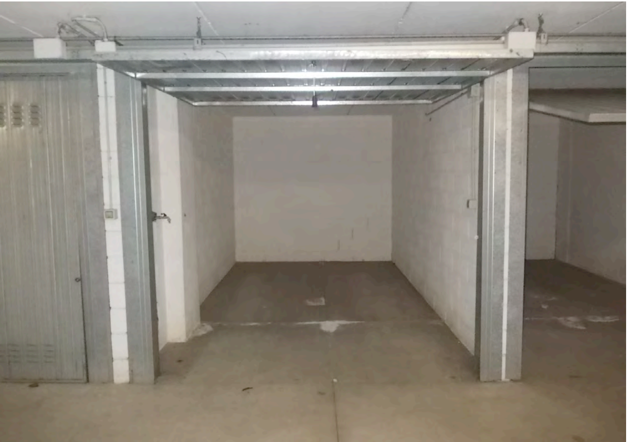
Autorimessa oggetto di vendita (o similare)
