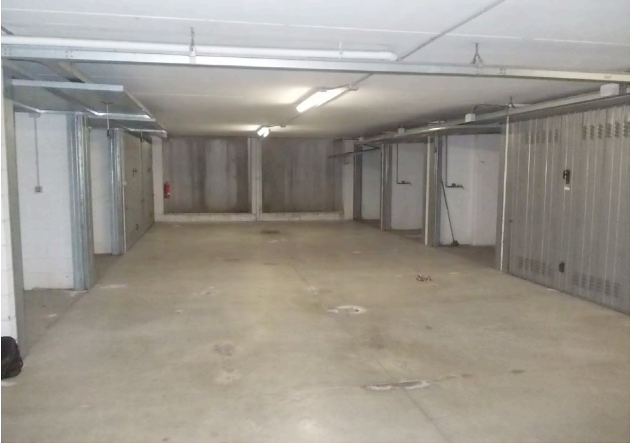
Corsello garages in comune
