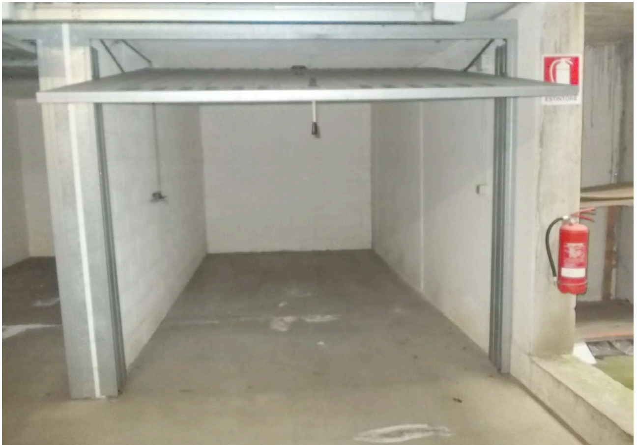
Autorimessa oggetto di vendita (o similare)
