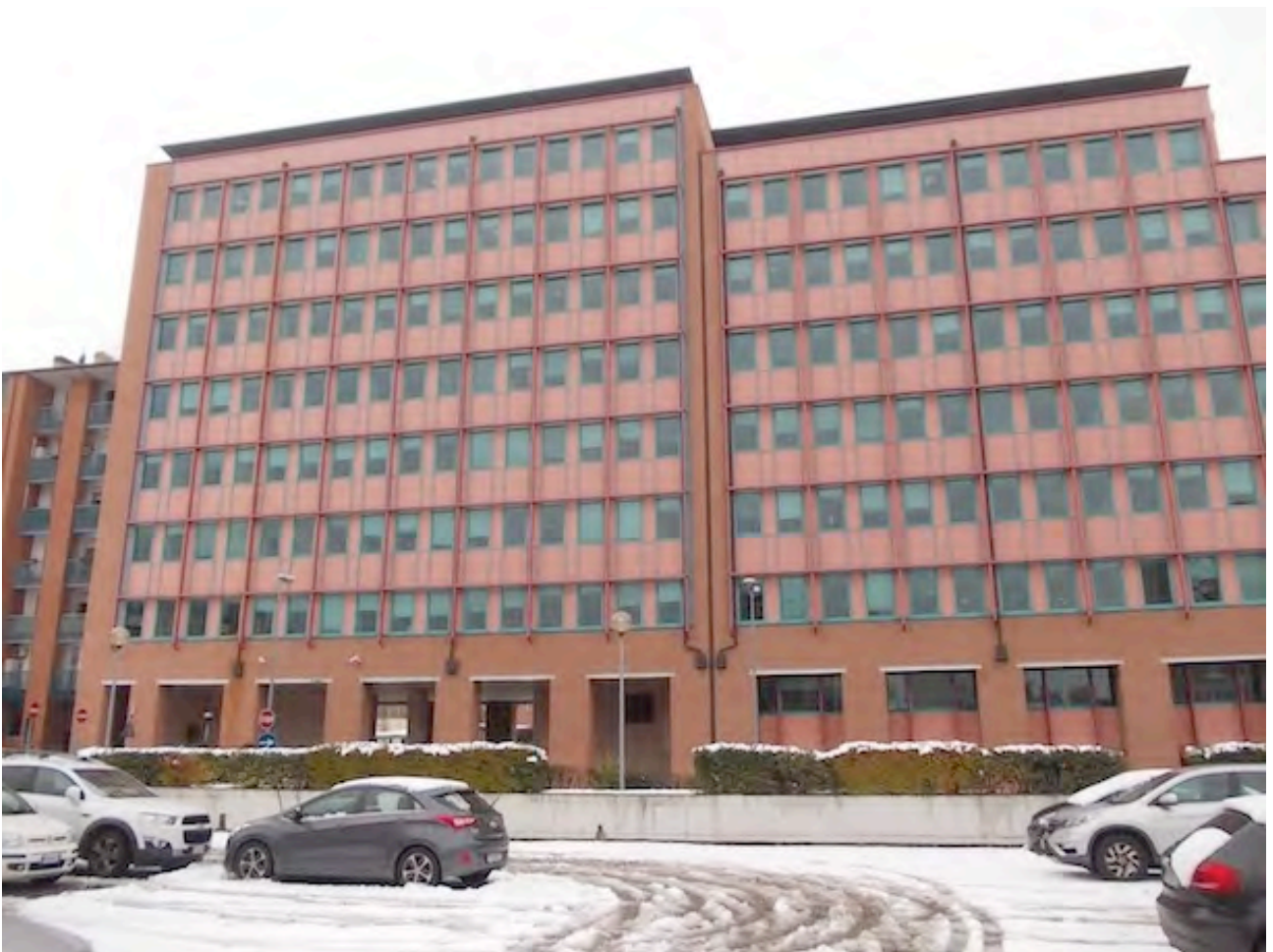
Lo stabile di cui l'immobile è parte
