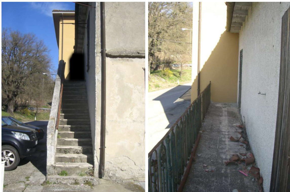
Figura 4 – Vista delle scale e del balcone
