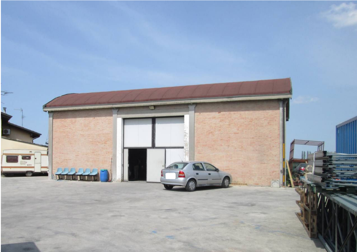
Vista esterna del fabbricato ed area cortiliva
