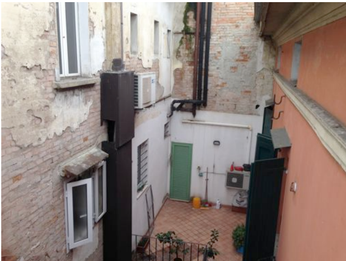
Vista della corte interna.
