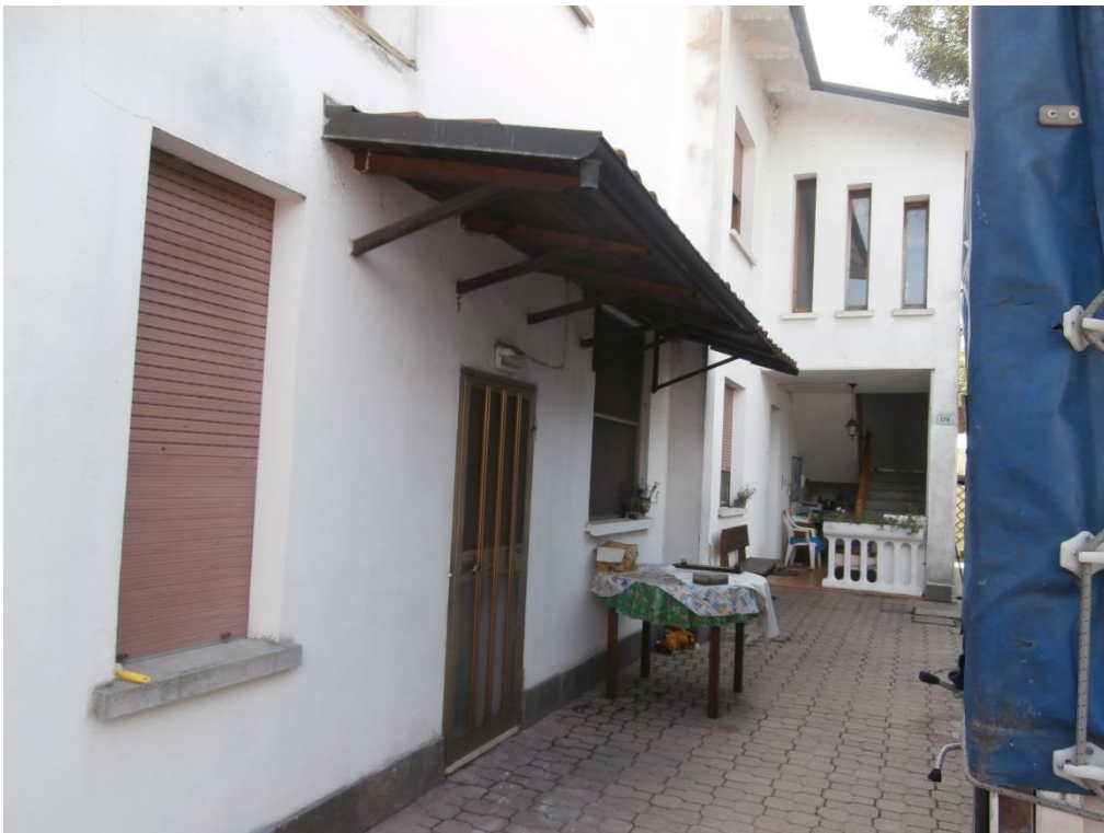
scorcio della corte comune ed entrata appartamento
