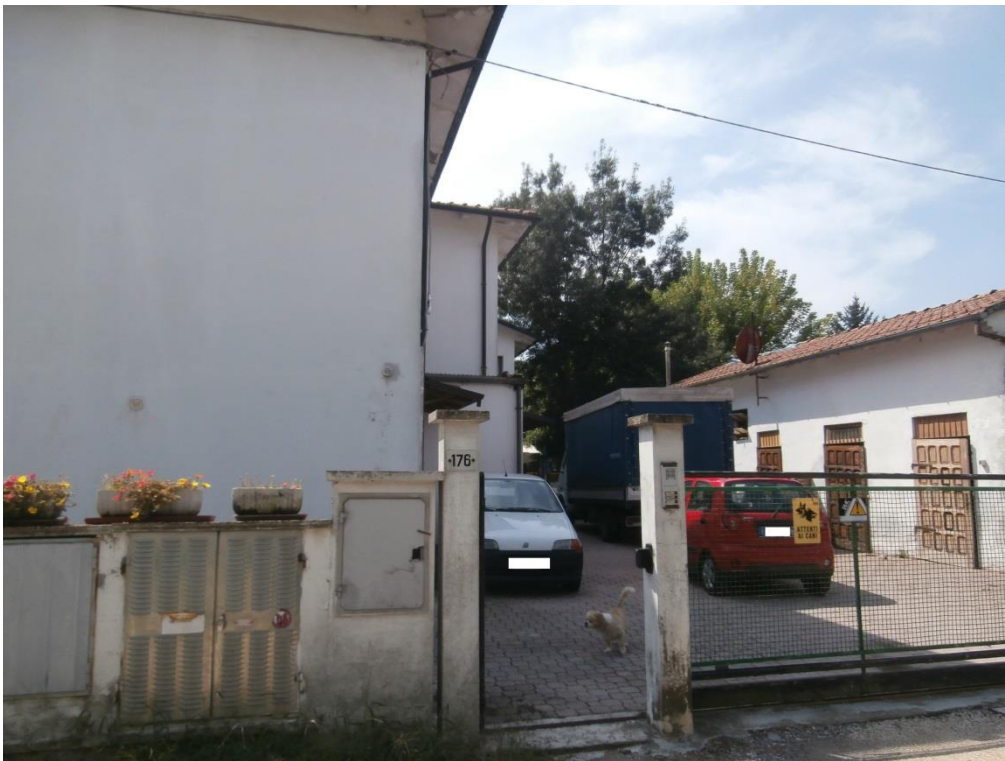
accesso alla corte comune, lato nord
