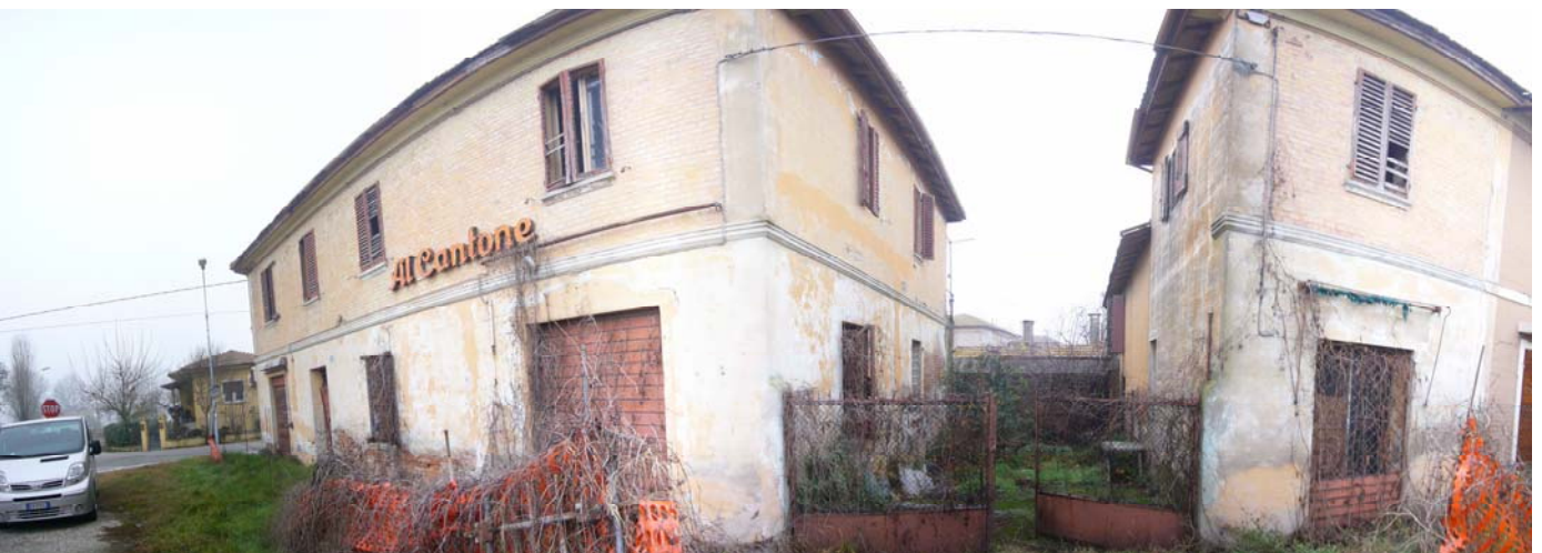
PARTICOLARE CORTE INTERNA CON ACCESSO SU VIA CA' BIANCA
