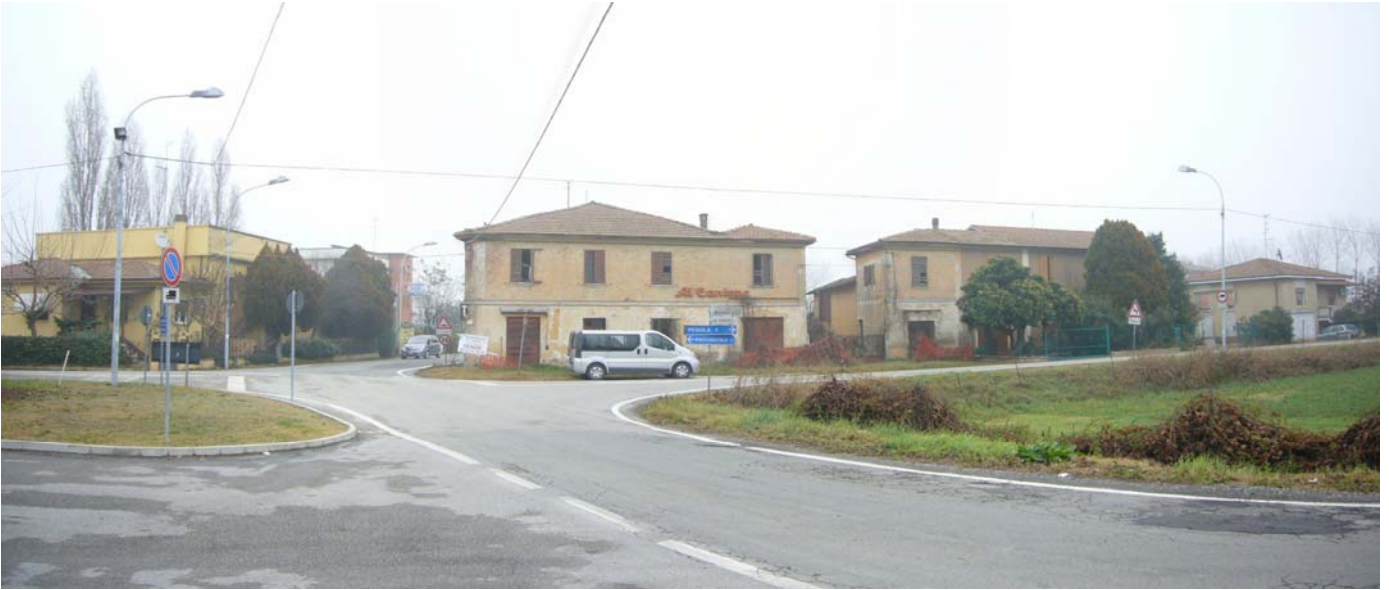
FRONTE SUD-INCROCIO VIA PONTICELLI-VIA CA' BIANCA
