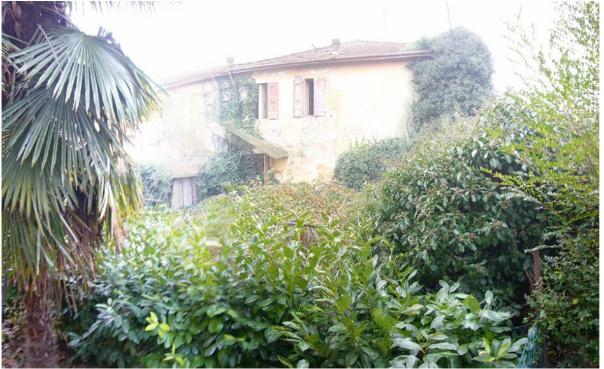
FRONTE NORD E CORTE POSTERIORE
