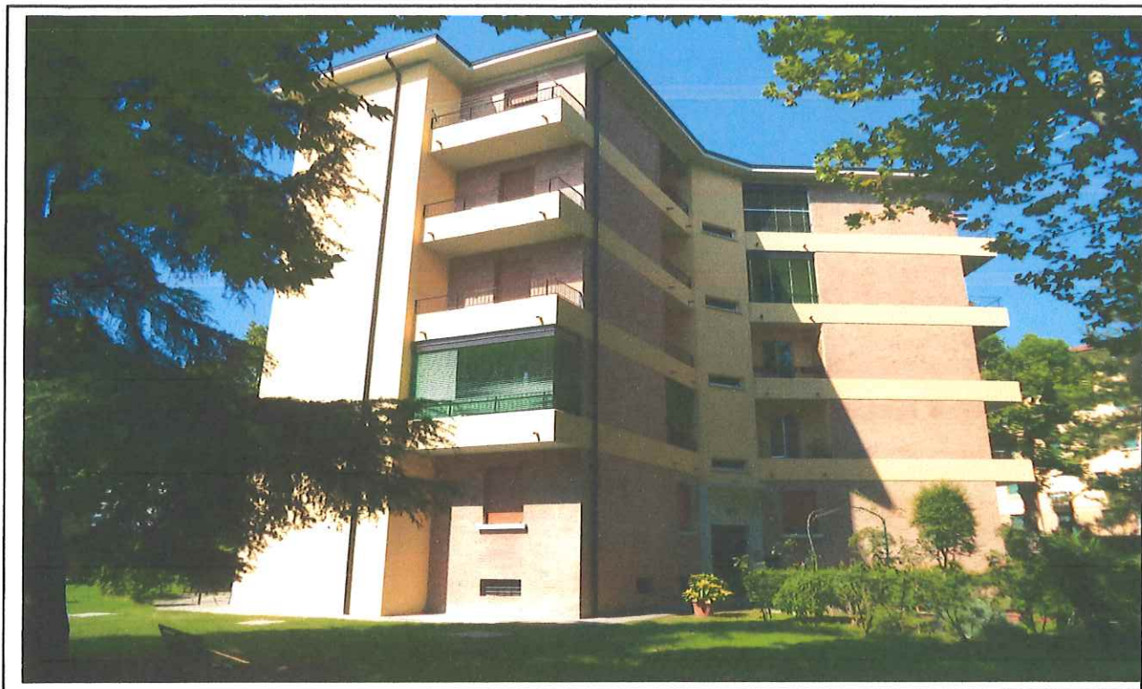
Foto n° 1 – Il fabbricato condominiale e la porta di ingresso ripresa sul lato nord
