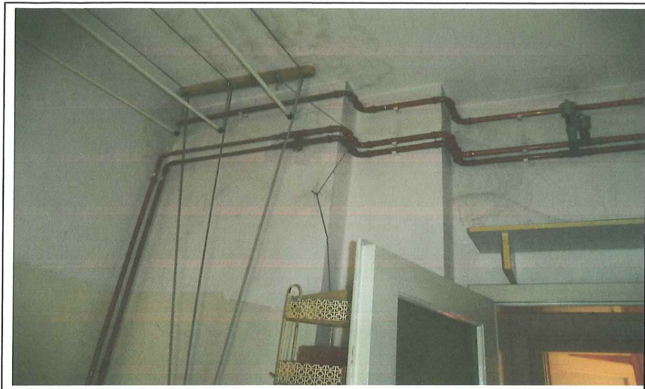
Foto n° 3 – Particolare del bagno
