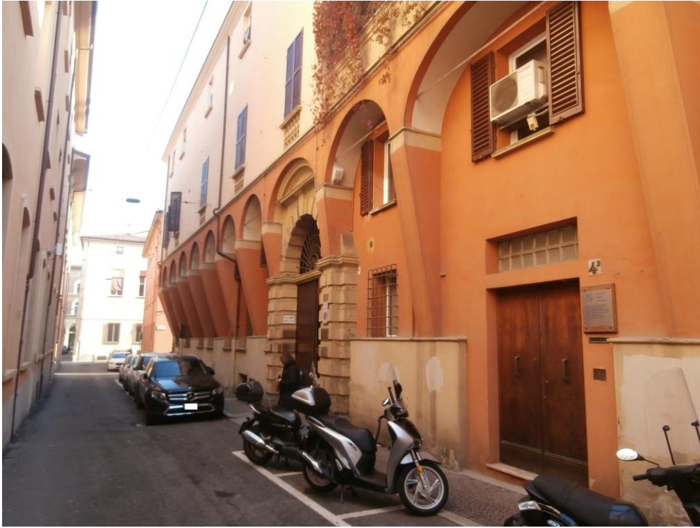
Fronte principale su via Morandi
