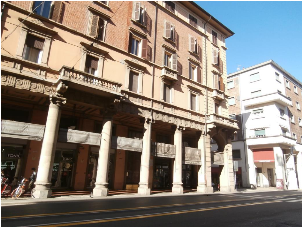
Fronte principale su via Matteotti
