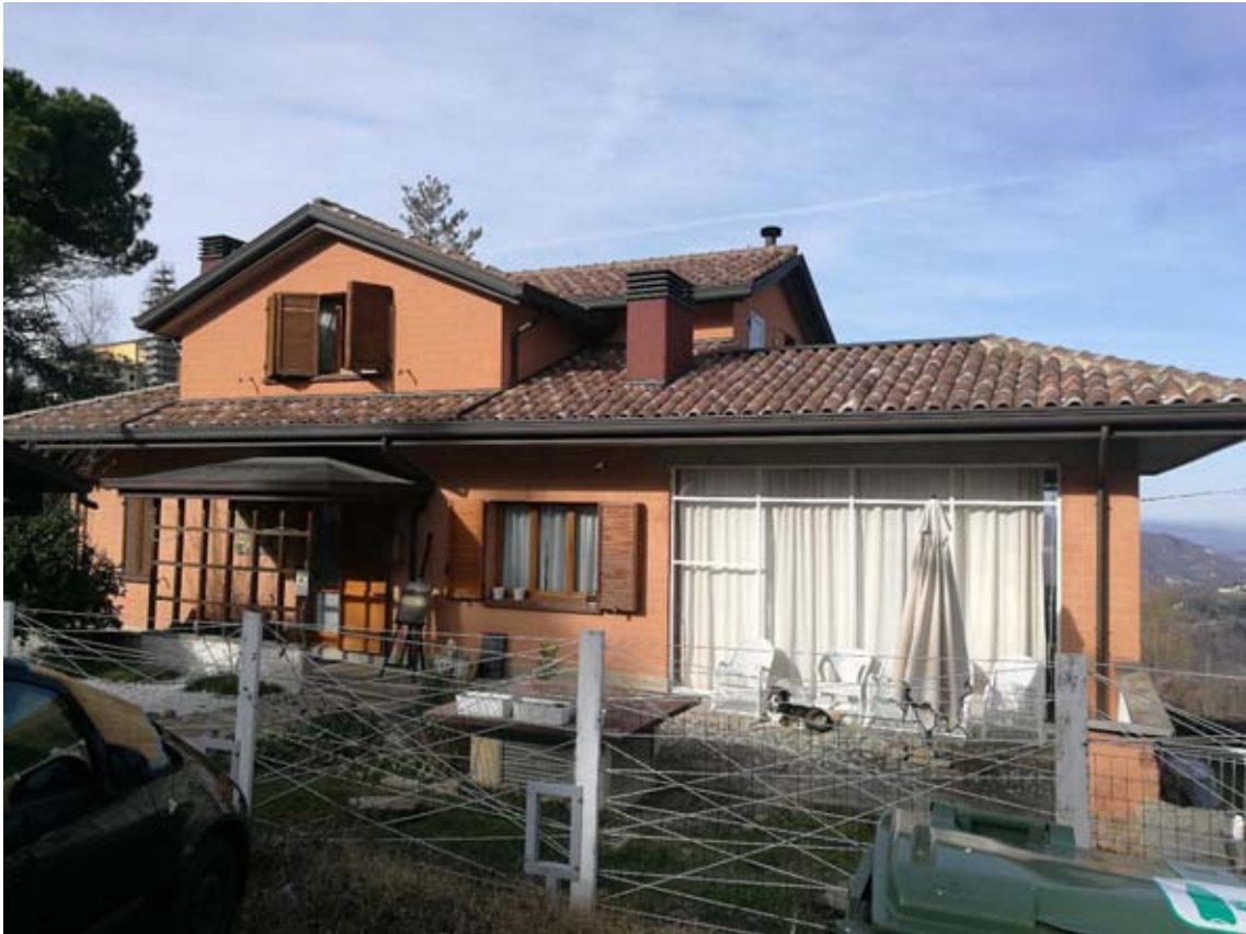
Vista esterna dell'immobile
