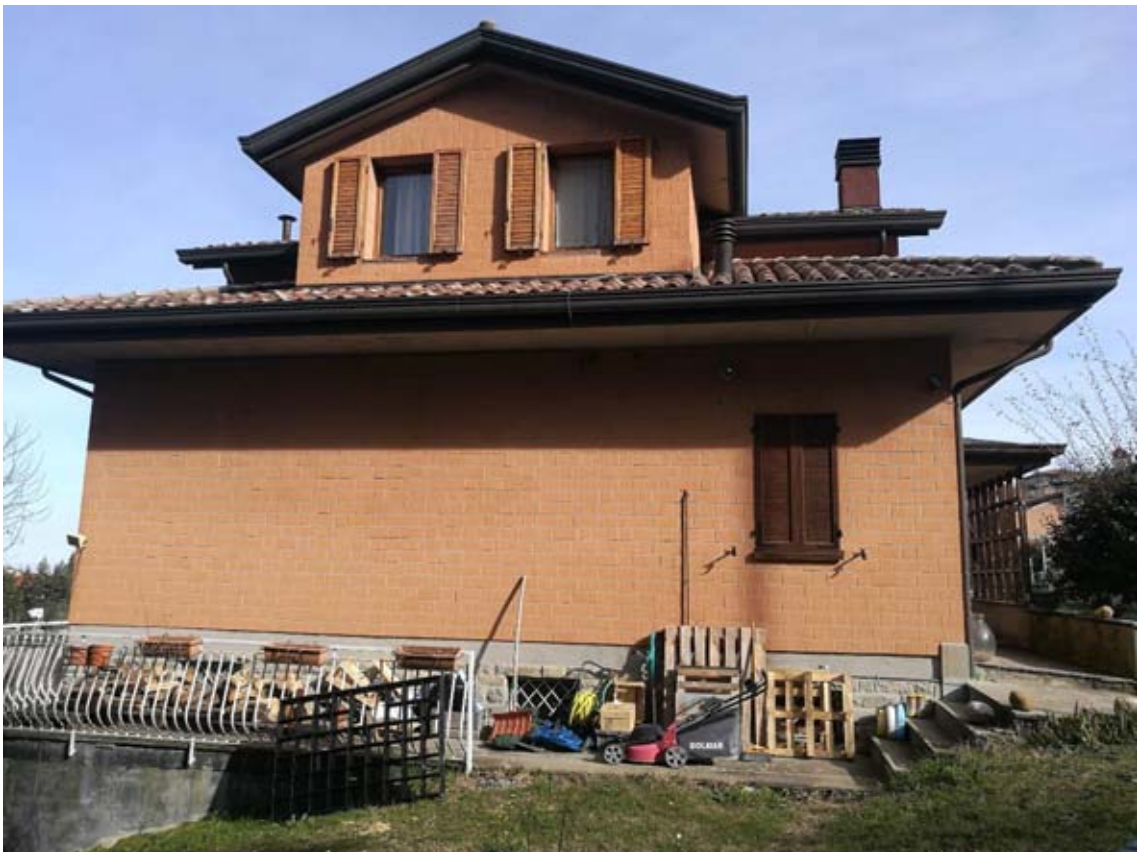
Vista esterna dell'immobile
