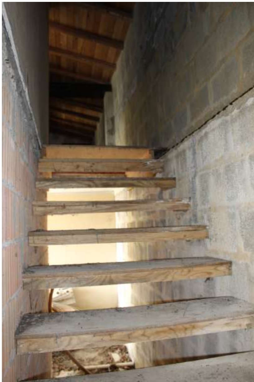
Scala interna di accesso al piano primo
