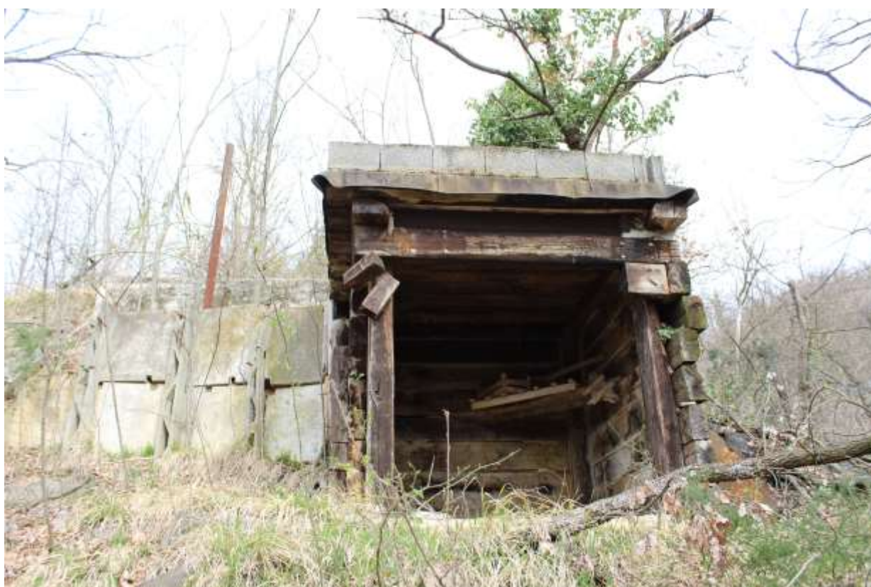
Fabbricato a magazzino demolito (piano seminterrato)
