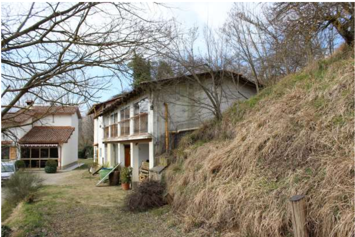
Vista lato est del fabbricato
