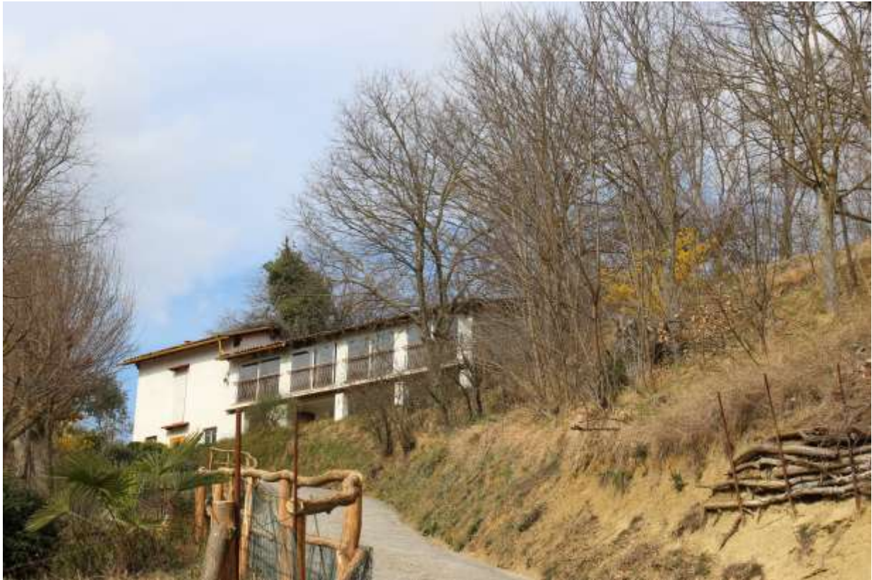
Fabbricato ad uso abitativo (in costruzione)
