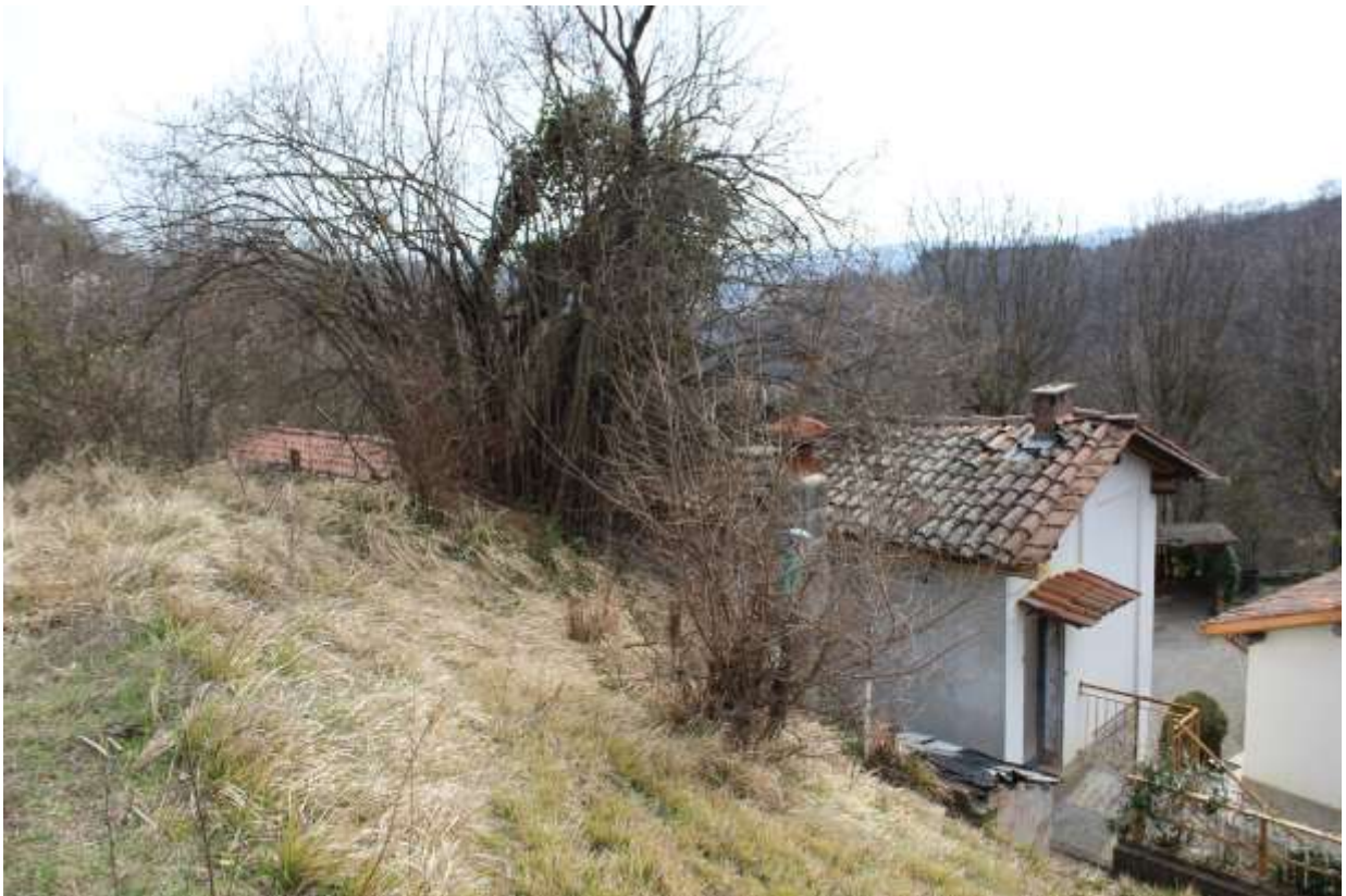
Vista del fabbricato da monte (lato nord)
