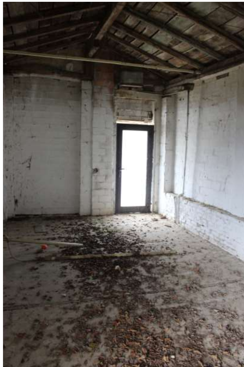
Camera al piano primo con uscita su scala esterna
