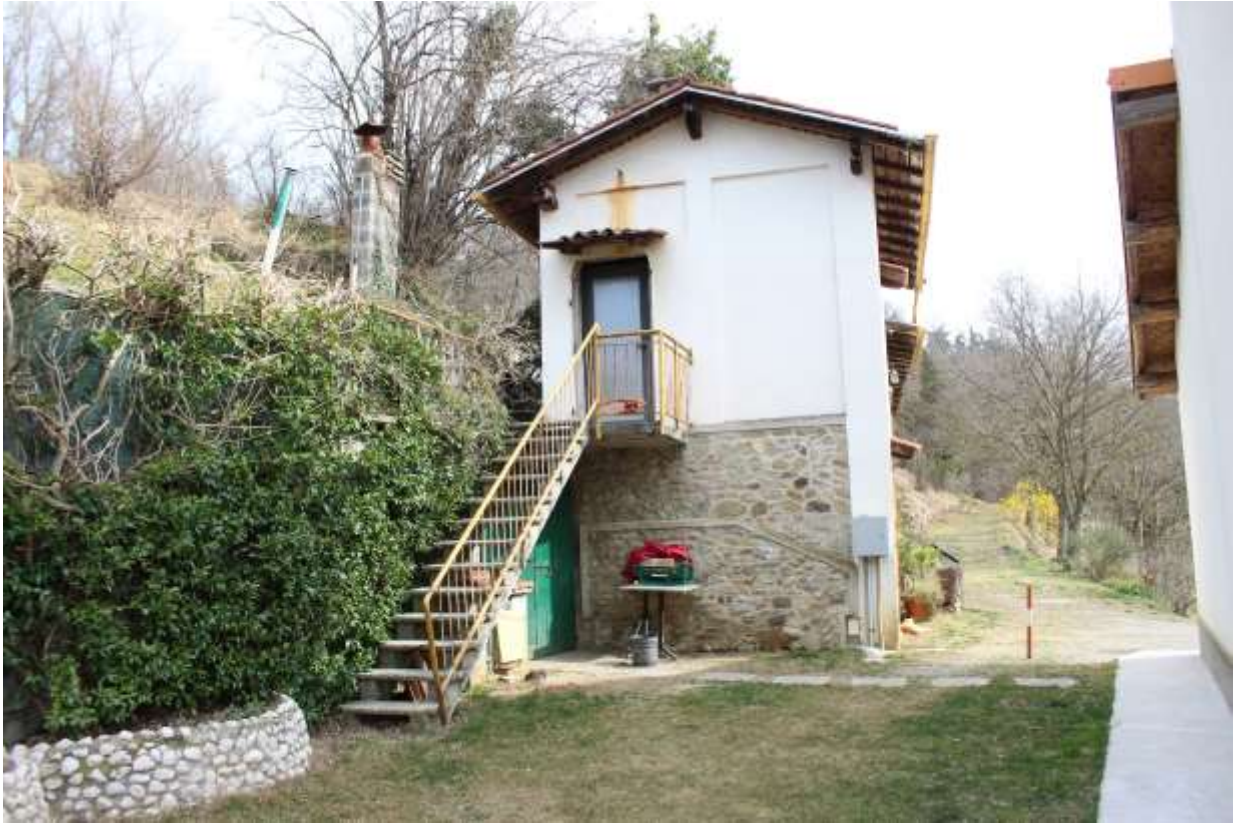
Vista lato ovest del fabbricato e corte con servitù di passaggio
