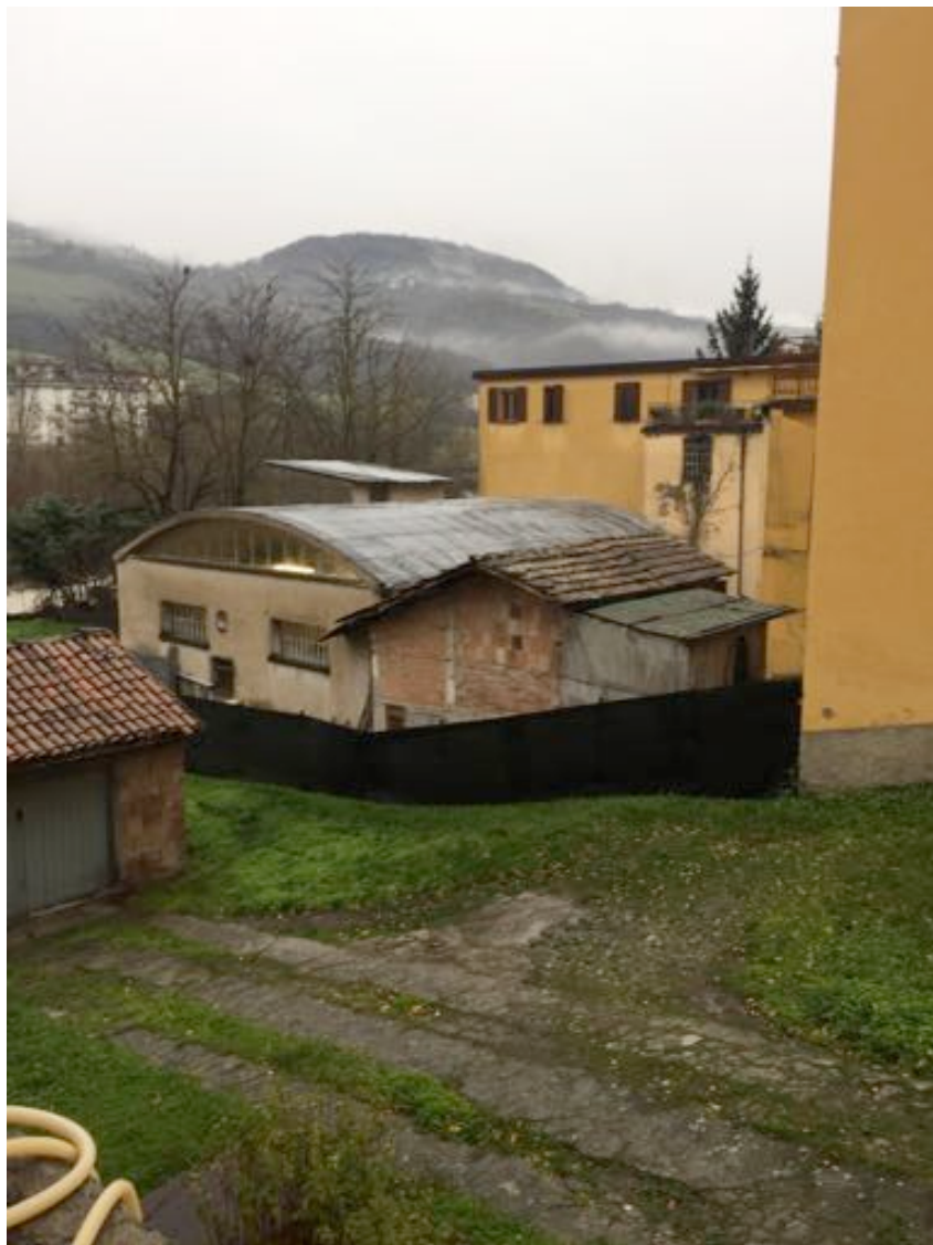
Vista dell'edificio dalla SS Porrettana.
