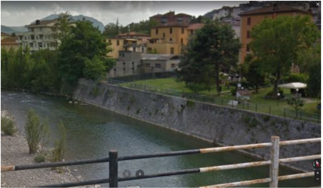
Vista dal ponte sul Reno del fabbricato pignorato.
