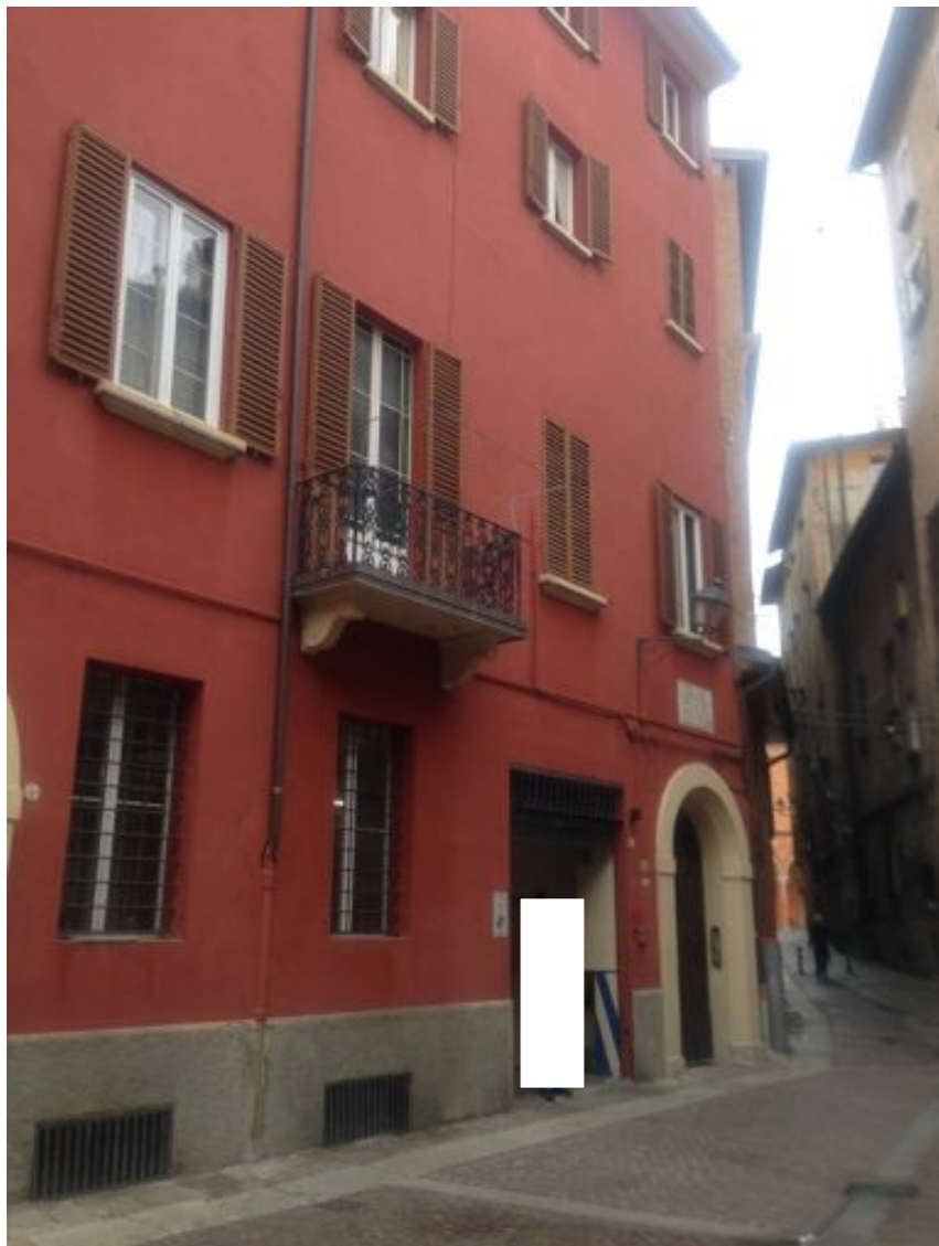
Vista dalla strada del civ. n. 1 di Via de' Pepoli. Nel centro storico del Comune di Bologna.
