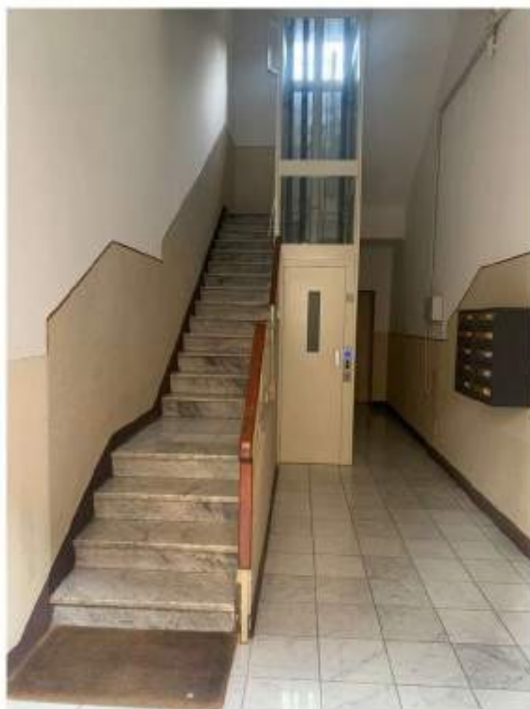
Vano scale al PT
