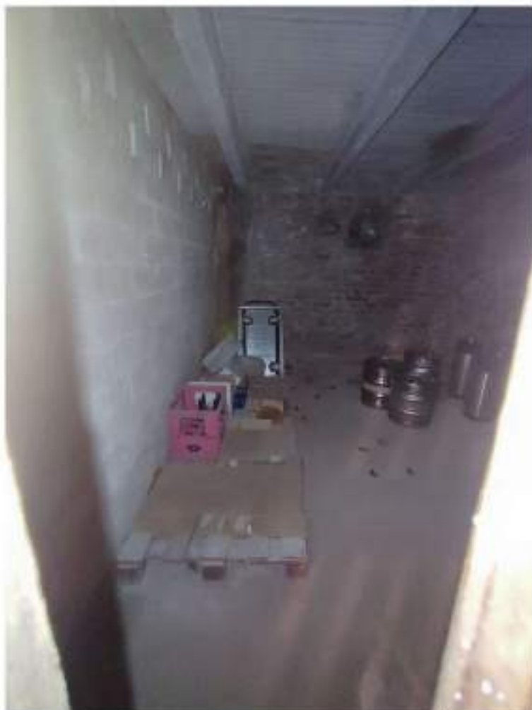
Interno cantina - in uso ad altra attività
