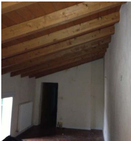
VISTA CAMERA PIANO PRIMO
