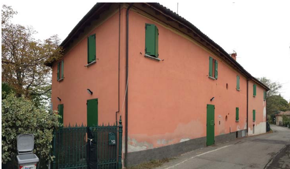
VISTA ESTERNA – LATO STRADA
