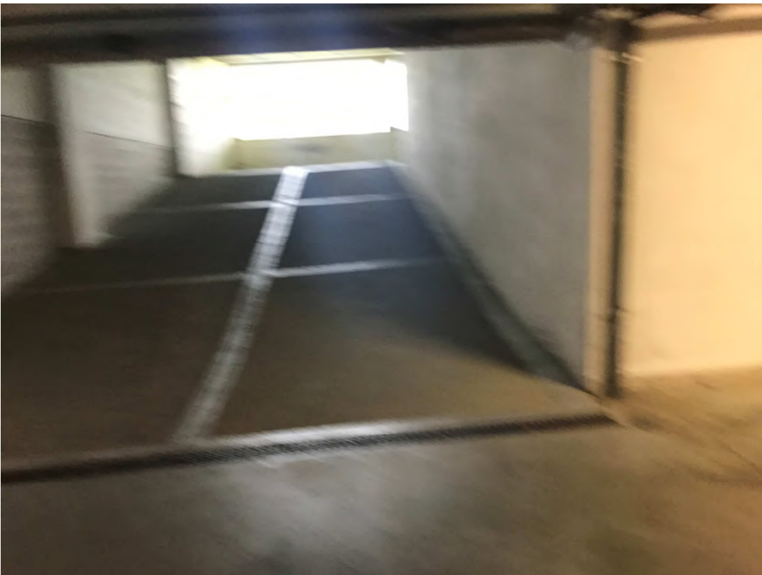
Rampa di accesso
