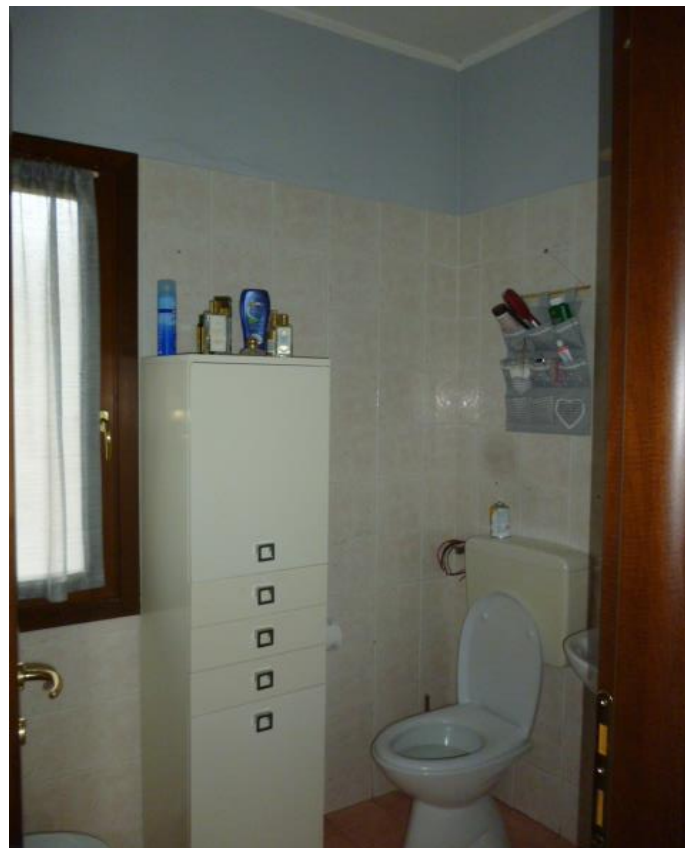
4- Bagno 1 (piano terra)
