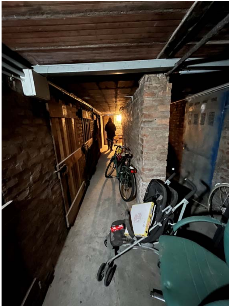
9. Ingresso comune alle cantine – Piano interrato
