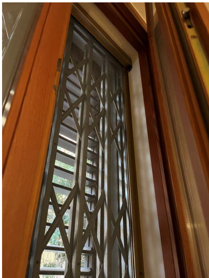
7. Dettaglio serramenti in legno, scuri in alluminio e inferriate metalliche
