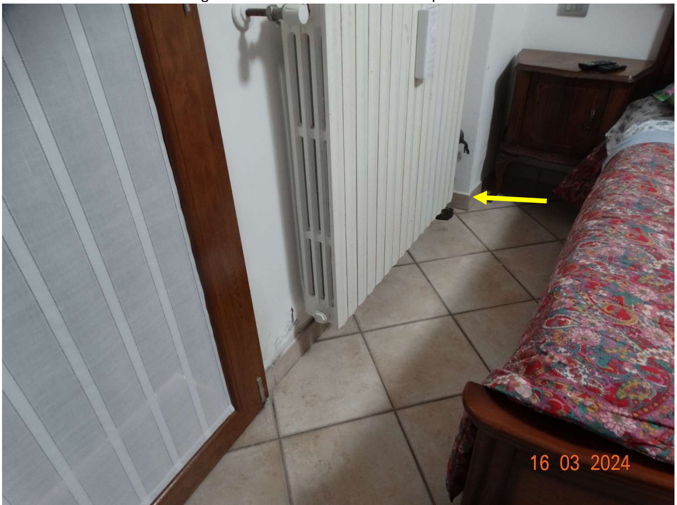
Foto n. 6 – Scatolare nella camera da letto matrimoniale.
