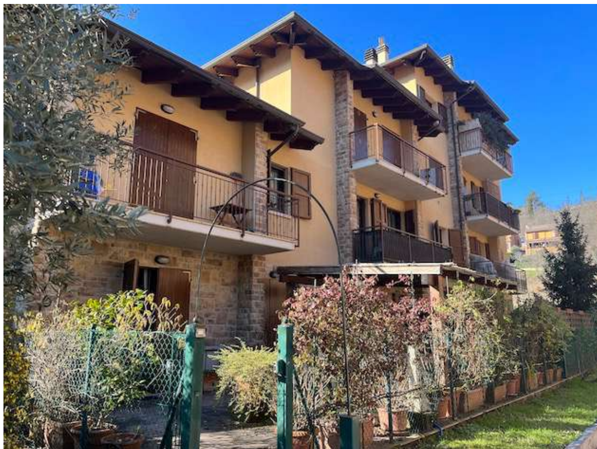
Lo stabile oggetto di stima – vista dal corsello di ingresso
