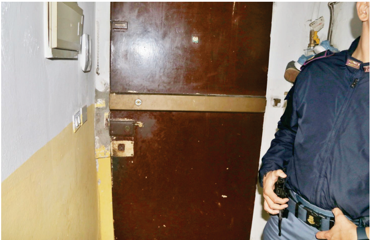
Figura 10. Porta di ingresso all'appartamento
