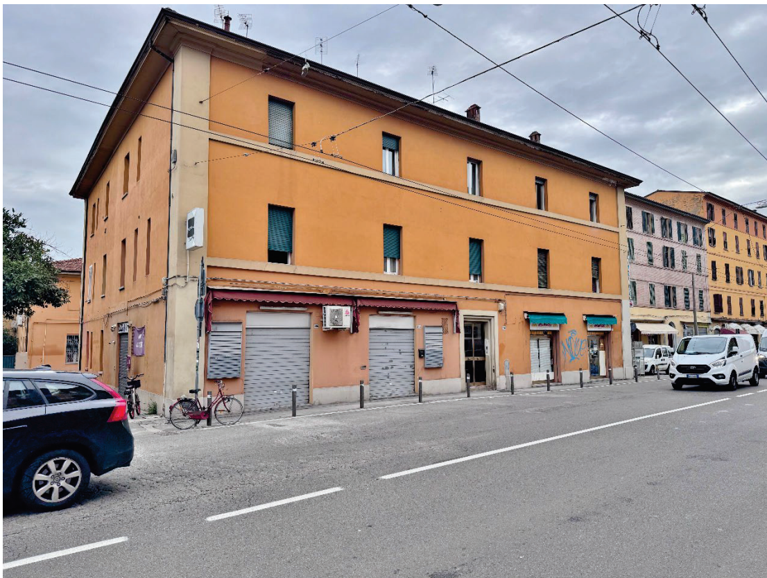
Figura 1. Fronte su via Massarenti
