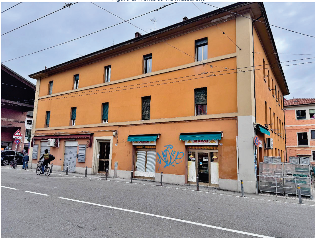
Figura 2. Fronte su via Massarenti
