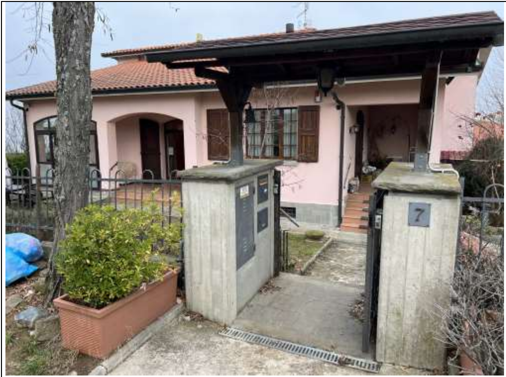
Fabbricato Via Borgotto 7 Monte San Pietro BO
