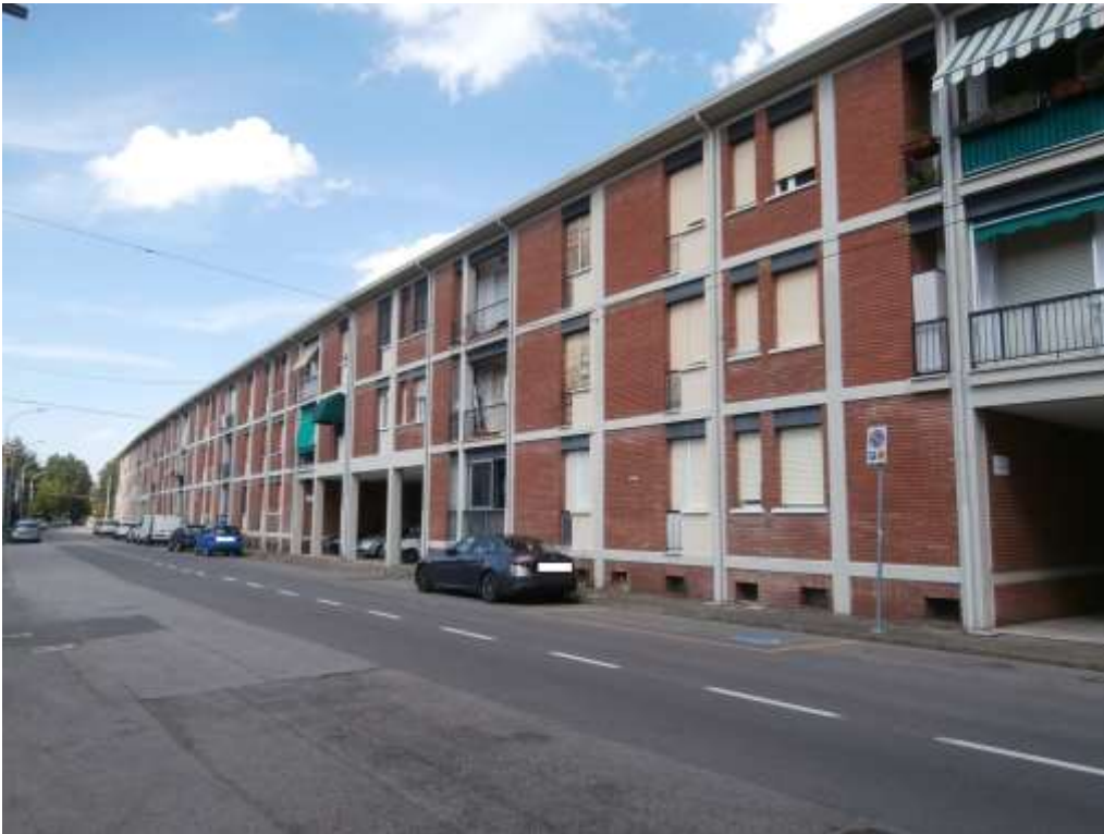
Fronte principale su via Rigola
