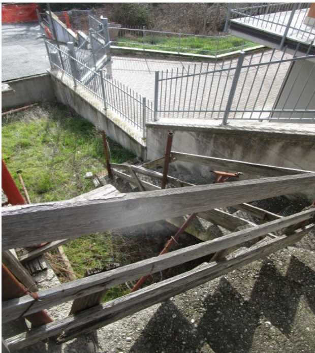
Figura 11: Scala esterna, che collega la corte, al primo ordine dell'edificio.
