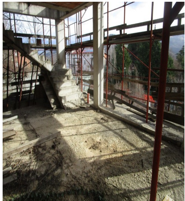
Figura 12: Passaggio tra il primo ed il secondo piano, dell'ossatura grezza.
