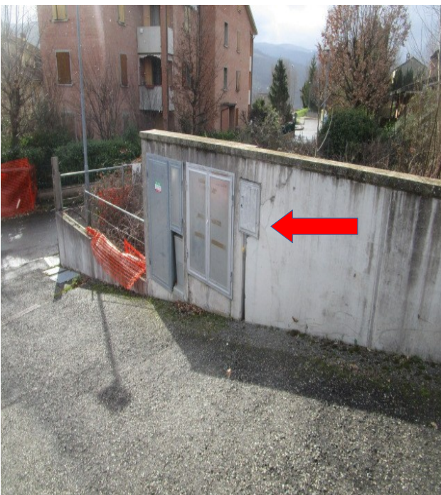
Figura 3: Armadiature per la predisposizione dei contatori, delle utenze domestiche.
