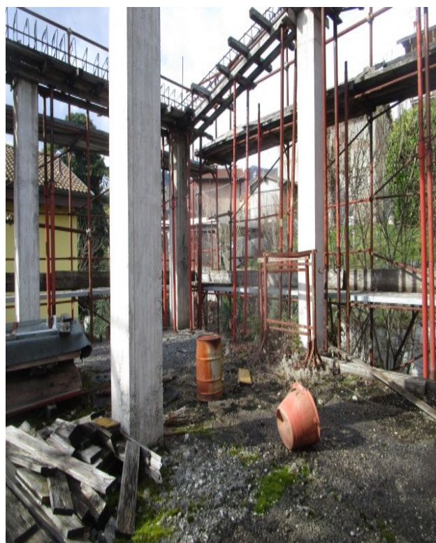
Figura 14: Sommità dell'armatura, con materiali ed attrezzature ignorati.
