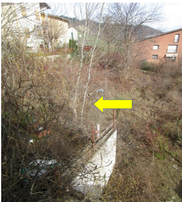
Figura 15: Frazione in terra, accatastata al foglio 93, particella 794, con relitto in cemento (si veda la freccia grafica in gialla).
