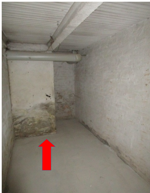
Figura 24: Tinaia di servizio, con setto murario, non rappresentato in pianta catastale.
