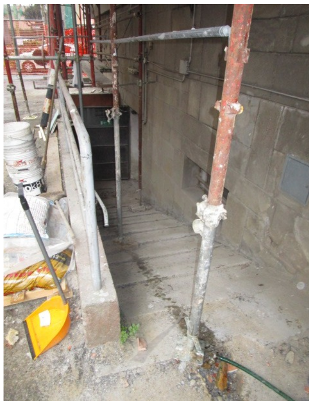
Figura 22: Doppio ingresso allo scantinato, sia ciclabile esterno, che dal corpo scale comuni ed interne al palazzo.
