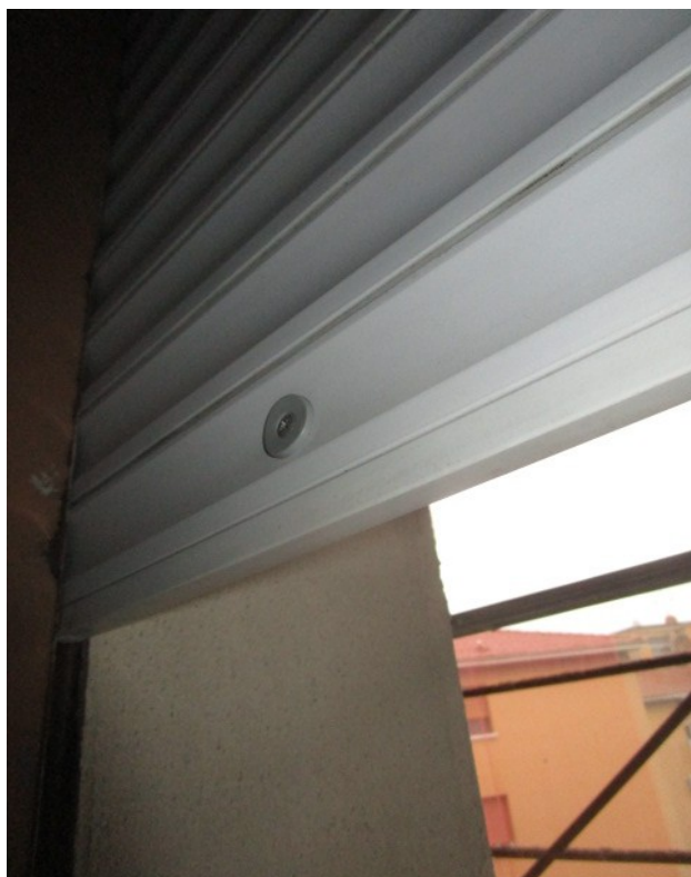
Figura 17: Tipologia dei sistemi oscuranti, a schermatura delle vetrate.
