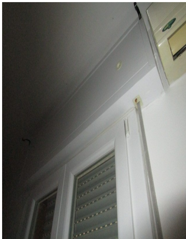
Figura 20: Tipologia dei cassonetti, di raccolta degli avvolgibili.
